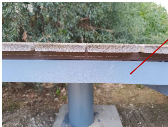
Φωτ. 2: Υπάρχουσα κατάσταση.
