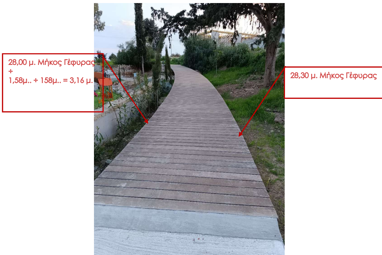
Φωτ. 1: Υπάρχουσα κατάσταση
